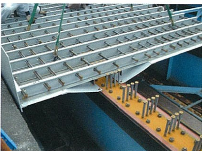
FRPパネル設置状況
