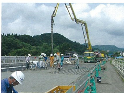
コンクリート打設状況
