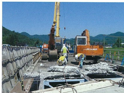
既設RC床版撤去状況
