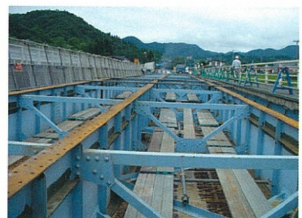
既設RC床版撤去完了
