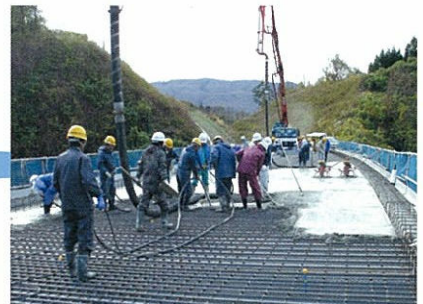
コンクリート打設
