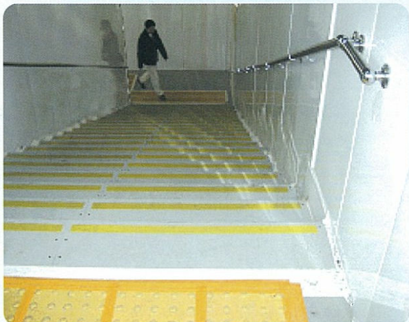
京浜急行田浦駅改良工事
