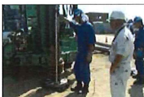
STEP 1 正確な杭位置とレベル止め
