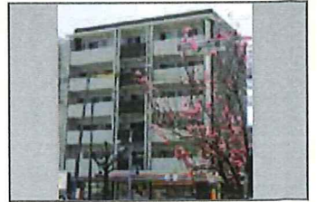
兵庫県 共同住宅
