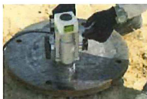
STEP 2 柱の水平方向誤差0
